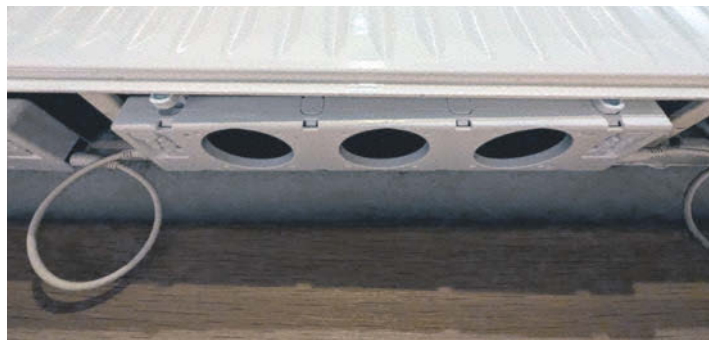
Der Heizungslüfter wird mithilfe von Magneten an der Unterseite zwischen den Heizungsplatten montiert.
