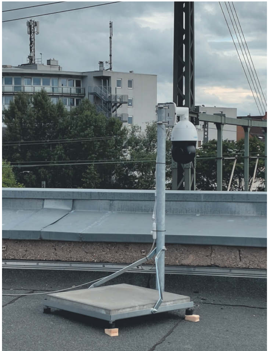
Da Löcher im Flachdach selten eine gute Idee sind, setzen wir für unser Projekt einen nicht-invasiven Ständer mit Gehwegplatte als Beschwerung ein. Eine Adapterplatte hält die Kamera am einen Meter hohen Mast.
