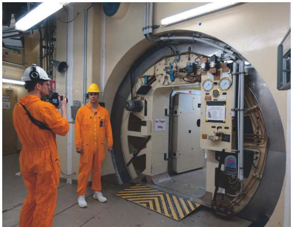
Durch diese Druckschleuse kamen und gingen die Brennelemente. Von außen nimmt sie ein Ladekran für den Weitertransport auf (im gelben Helm Kraftwerksleiter Bernd Kaiser).
