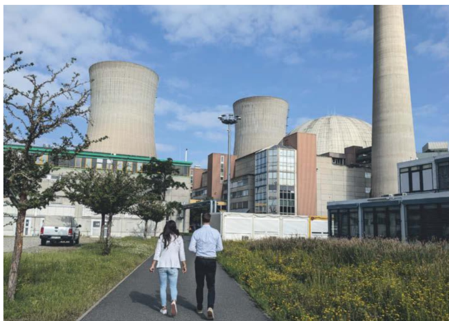
Auf dem Kraftwerksgelände herrscht noch einige Zeit reger Betrieb, es ist nur ein anderer als während der Stromerzeugung.
