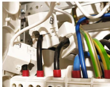
Bild 5: Die sogenannten Splitcore-Stromwandler sind aufklappbar, sodass sie leicht an die Kabel angeschlossen werden können.
